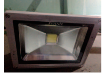
溶接ロボット工程内の照明灯はLED投射灯に交換
