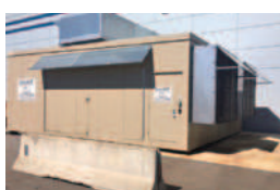
屋外エアコンプレッサー室 (2か所のうちの1か所)
