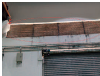
改善前のシャッターと開放式ルーバー
