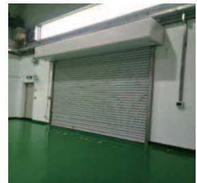
改善後のシャッターと閉鎖式ルーバー
