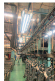
工場内に設置したLED照明
