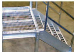
凍結防止対策を行った階段
