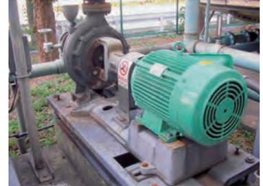
高効率IPMモータを搭載した循環ポンプ
