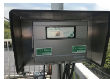
秩父工場は工業団地内にあり、排水は近隣企業とともに行政で管理している排水処理場で再度クリーン化され河川に放流されます。
