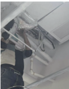
配管周囲を防水材でカバー
