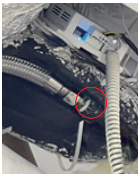
パッキン交換
